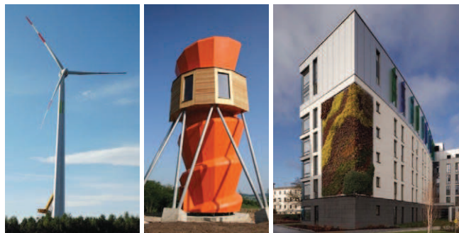
Rys. 7. Przykłady nietypowych obiektów o konstrukcji z płyt z CLT, od lewej: turbiny wiatrowe (Niemcy), Snail Shell Tower (Austria), budynek Uniwersytetu Anglii Wschodniej (Wielka Brytania) [9]
